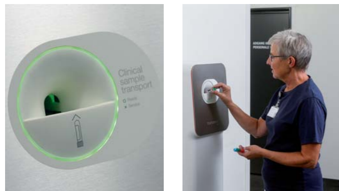
将样品管放进 Vita发送站入口。
