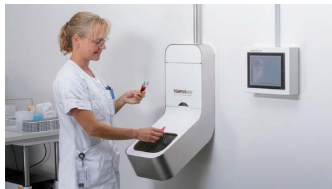
样品达到接收装置，并在此处由实验室人员取走。
